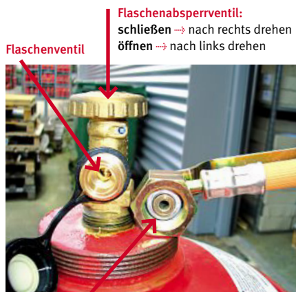
Bild 2: Großflaschenanlage mit Hochdruckschlauch
