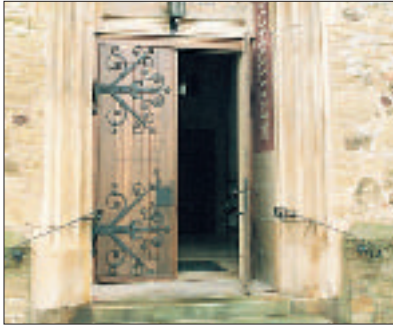
Bild 1: Sichere und tragfähige Zugänge
